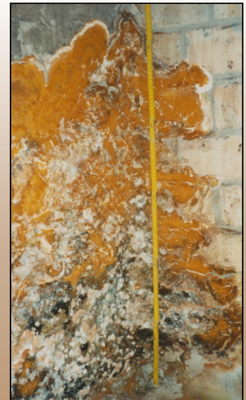
Echter Hausschwamm ( Serpula lacrymans ) Fruchtkörper auf Mauerwerk
